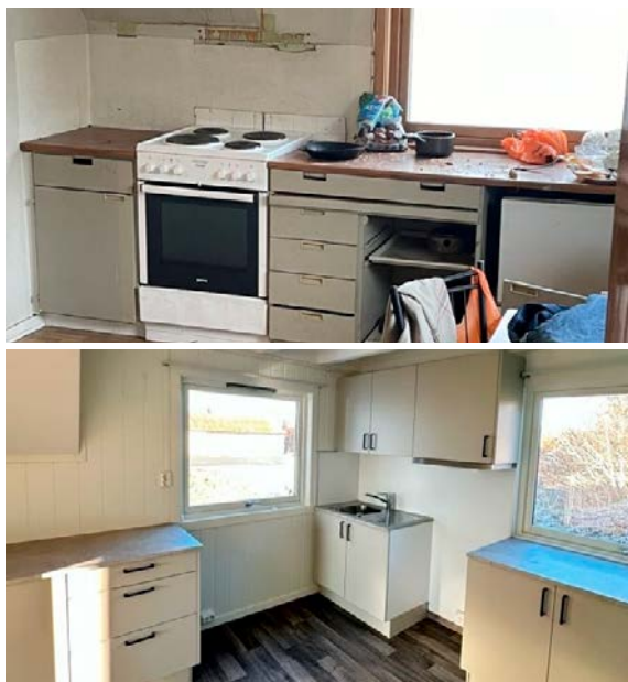
Bilde av kjøkkenet i den ene boligen før og etter istandsettingen. Foto: Brønnøy kommune
