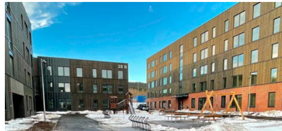
Familieboligene omkranser en egen lekeplass. Foto: ProBea AS
