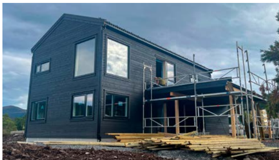
Eneboligen kort tid før den ble ferdigstilt. Foto: Tosip AS
